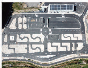
市民への電源供給と 大規模貯水が可能
